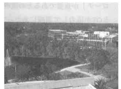
写真3 Mayo Clinic (Davis Building) より西南方向を臨む
